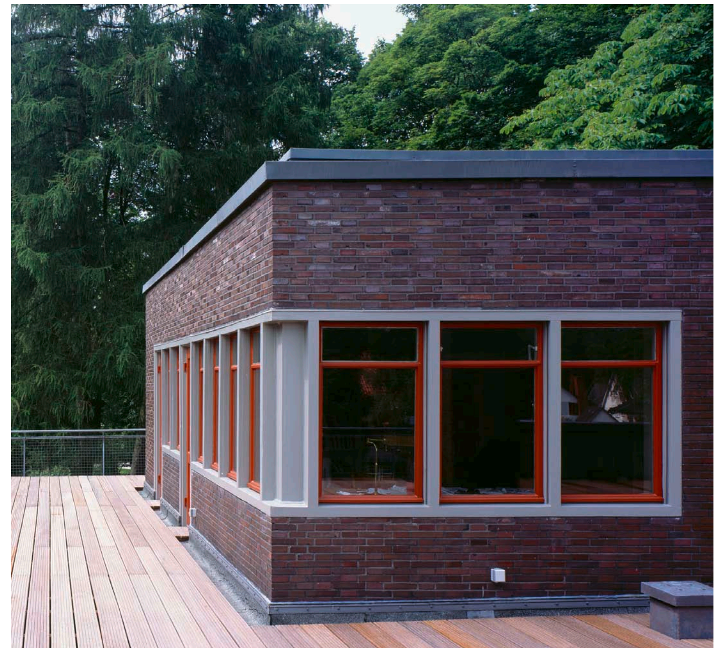
Bild 09: Haus Müller-Drenckberg, Fensterdetail Dachgeschoss
