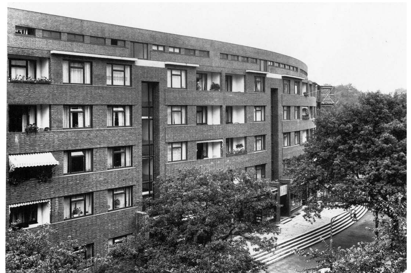
Bild 10: Wohnhäuser Burmeister um 1930, Arch. Karl Schneider
