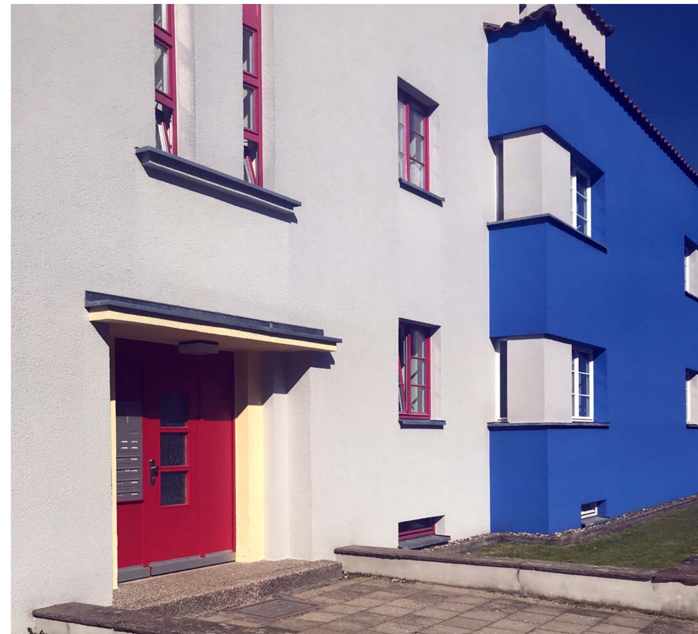
Bild 04: Siedlung Italienischer Garten, Arch. Otto Haesler, rekonstruierte Farbfassung der Fassaden
