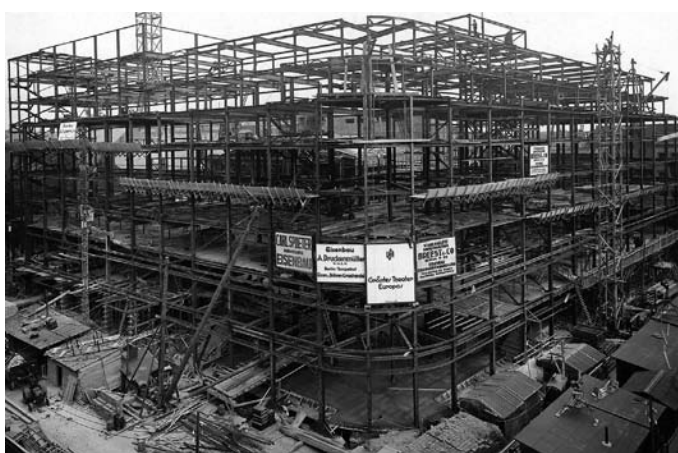
Bild 10: Stahlskelettkonstruktion – das Deutschlandhaus im Bau
